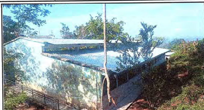
Foto1: Sustitución de cubierta de lámina
