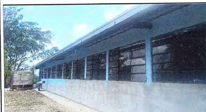
Foto 3: Reparación y cernido de paredes
