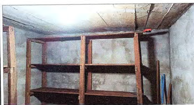
Foto 5: Impermeabilización de losa y reparación del sistema eléctrico
